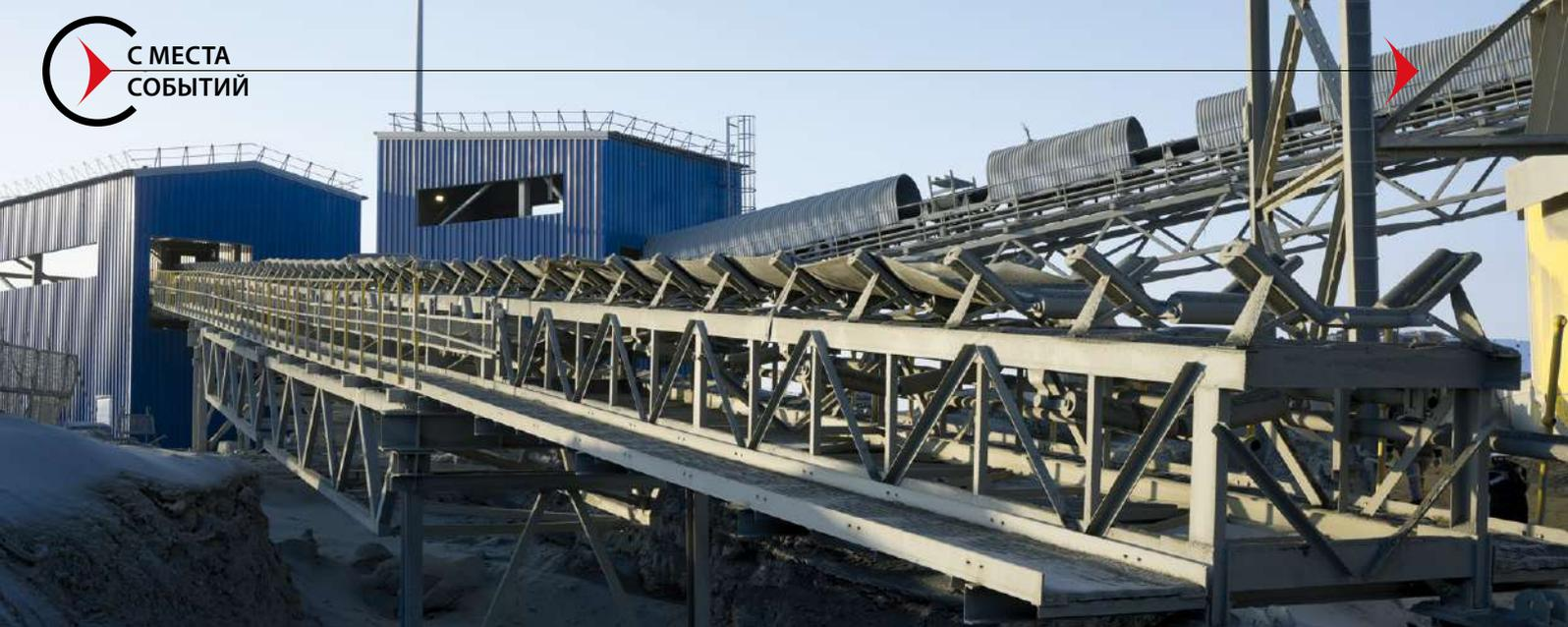
на фабрике началось строительство нового дробильного участка, который состоит из двух корпусов дробления и грохочения, связанных между собой конвейерными галереями. Новый комплекс должен помочь предприятию выйти на упомянутые 4 миллиона тонн и позволит перевести действующую линию в резерв.
