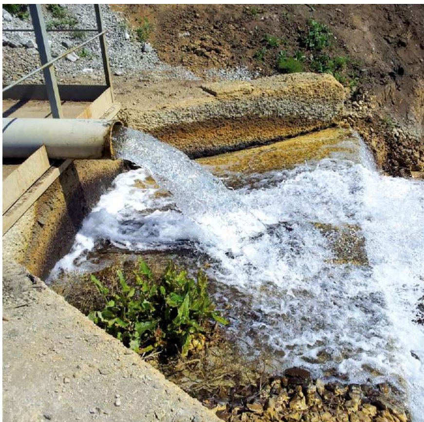
Рис. 2. Осветлённая вода после отстойника-флокулятора ЭП ОФ.
