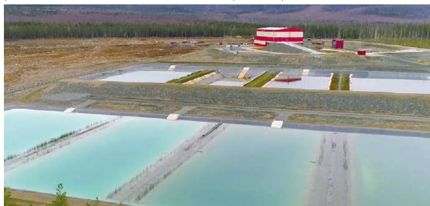
Рис. 4. Сооружения биоинженерной защиты (стадия строительства).
