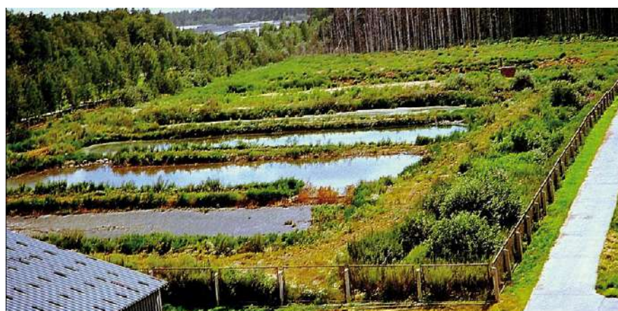
Рис. 5. Сооружения биоинженерной защиты (стадия эксплуатации).
