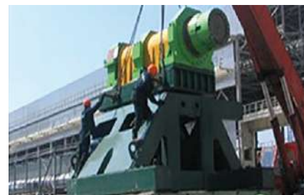
Рис. 7. Последовательность монтажных работ мельницы самоизмельчения с размером барабана 5.0x1.33м
